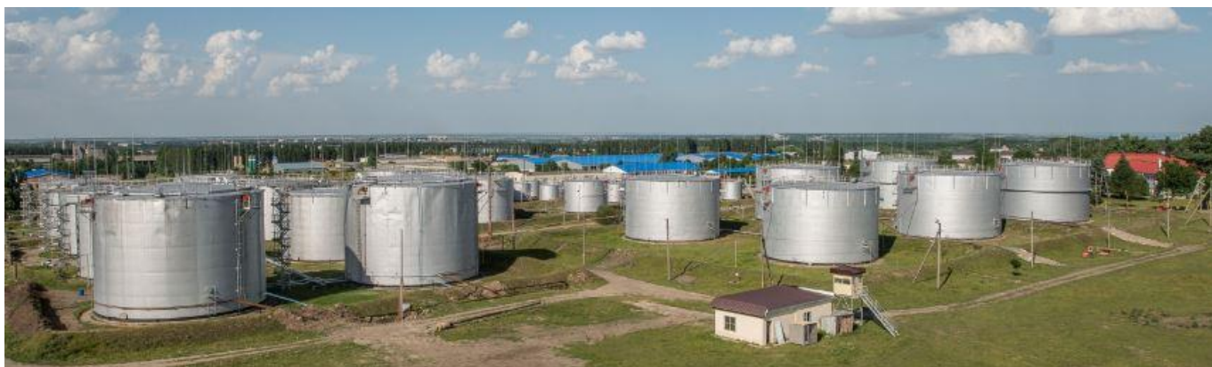
Резервуарный парк, г. Ставрополь
