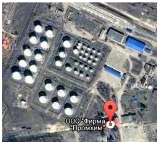
Нефтебаза г. Ставрополь
